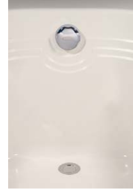
Figura 1: Desagüe / Rebalse Jacuzzi.
