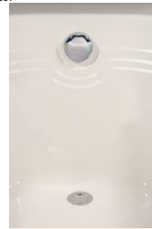
Figura 1: Conjunto Desagüe Rebalse Remoto.
